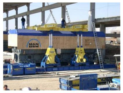
Entladung und Fundamentlieferung von vier Dieselmotoren je 270 tons im Kraftwerk in Batman, Türkei
