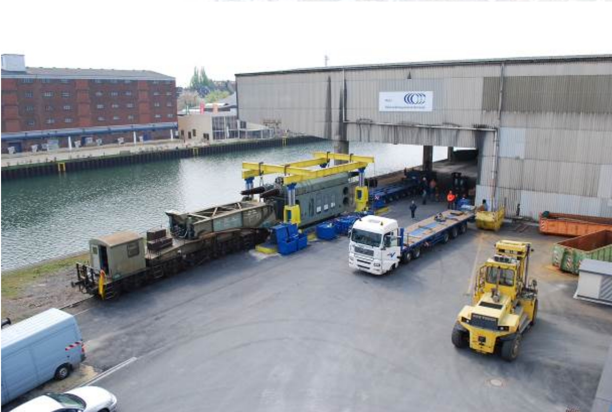
Entladen eines Transformators 180tons aus Bahnwaggon
