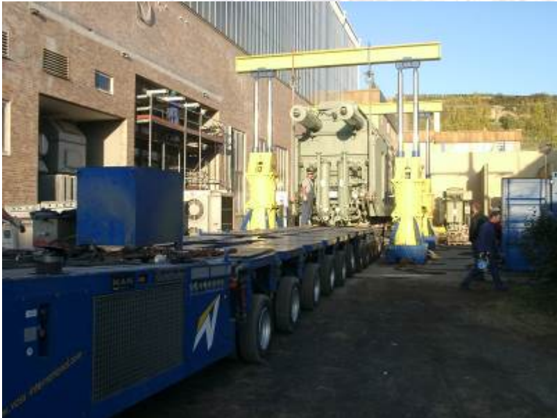
Entladen eines Transformators 220 tons
