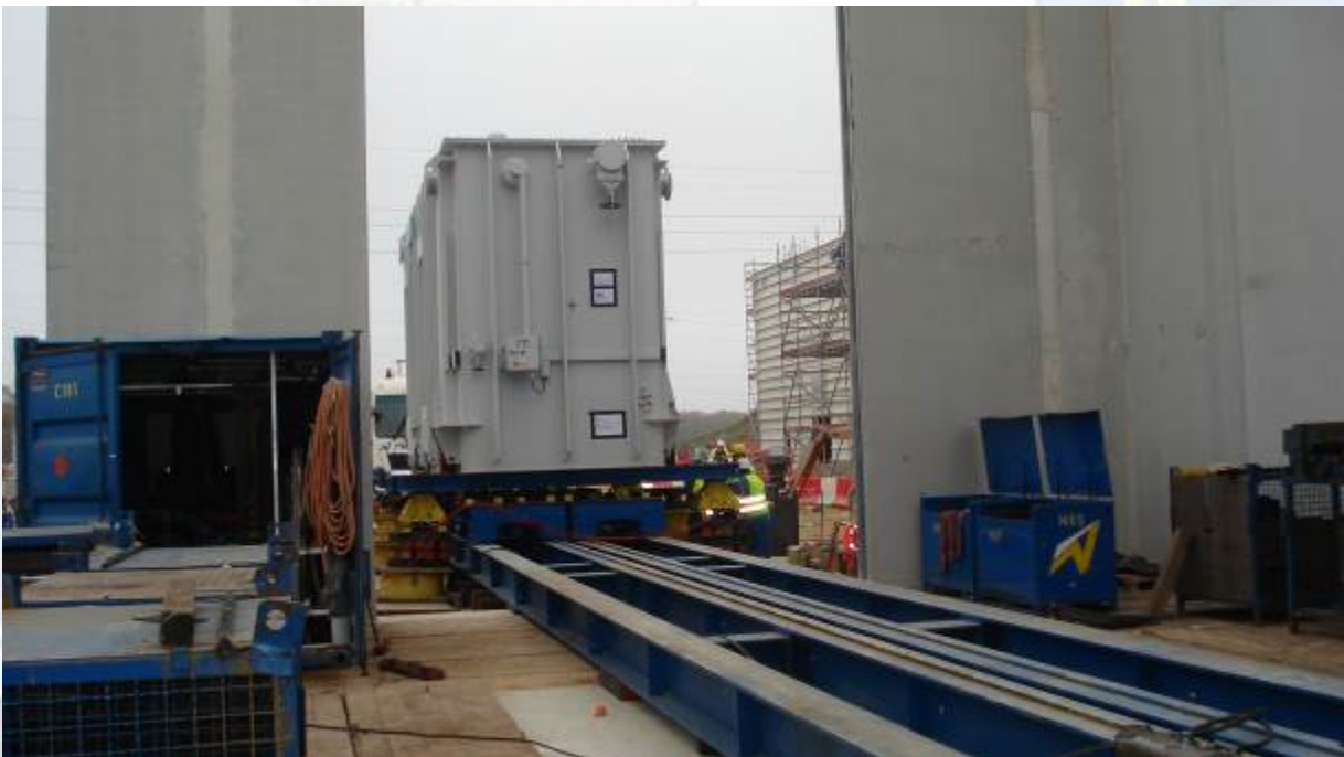
Verschub Transformator 210 tons über Grube auf Fundament
