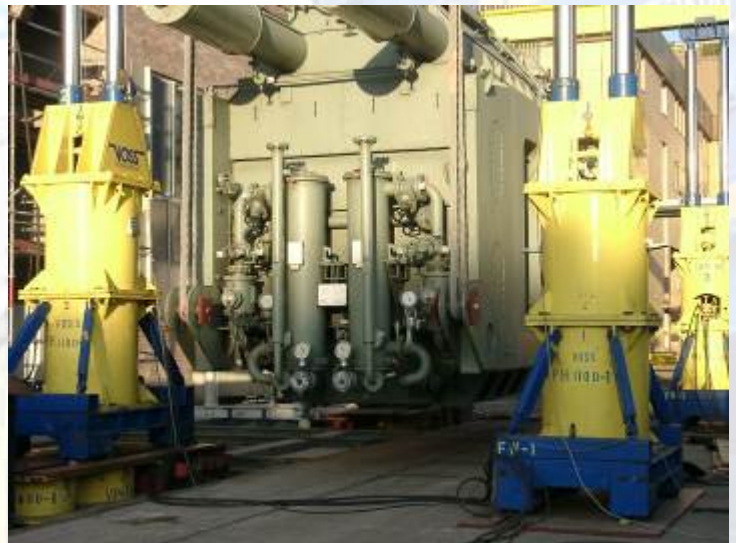
Entladen eines Transformators 220 tons
